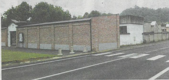
Il cimitero di Corneliano. Tra i progetti inseriti nel piano delle opere 2016 figura la rimozione completa delle coperture di amianto e la sostituzione con rivestimenti a norma
